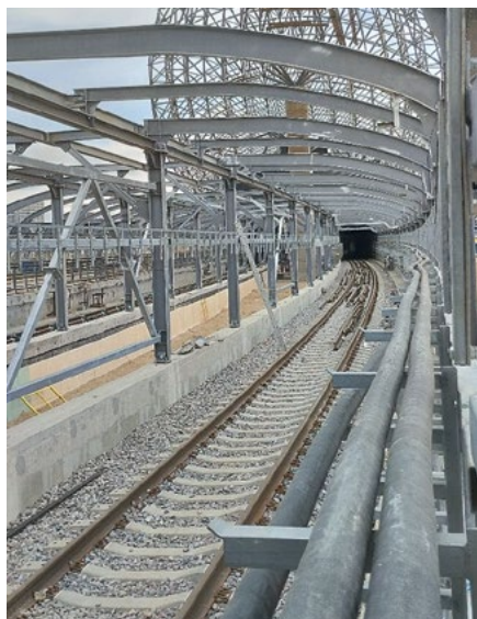
Монтаж металлических конструкций покрытия метро.
