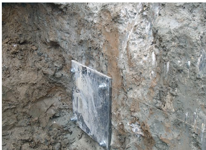
Устройство распорной системы в котловане.
