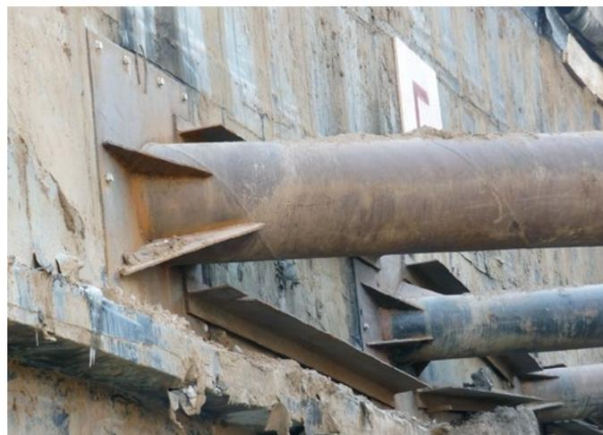
Устройство распорной системы в котловане.
