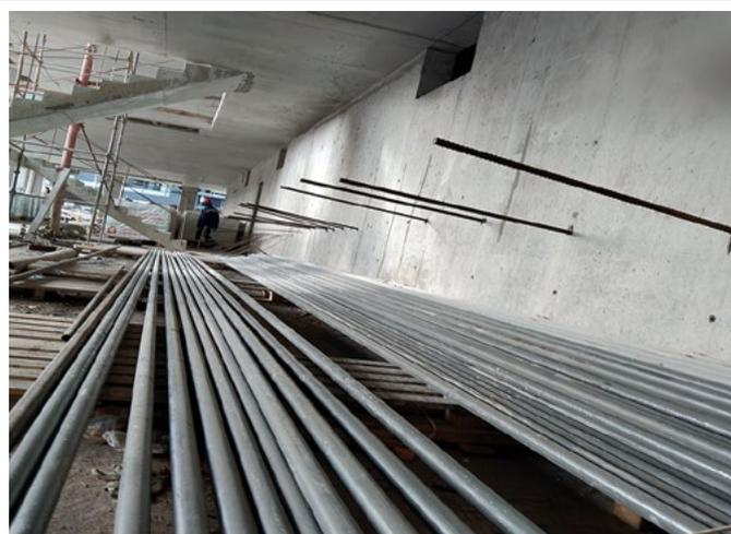
Устройство арматурных выпусков путем вклейки стержней по технологии инъектирования VME 600.
