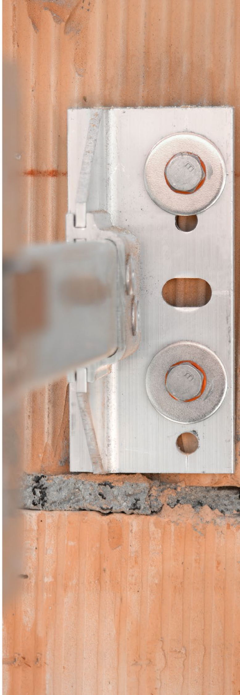
Конический бортик обеспечивает контролируемую глубину установки.
